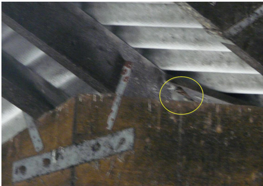
Foto 2b huismus in de nok bestaande stal / loods
