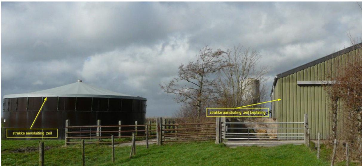
Foto 7. Aansluiting zeil en beplating
