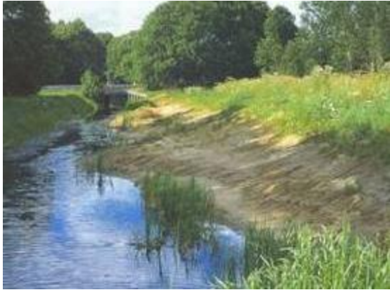
Waterloop met flauw talud
