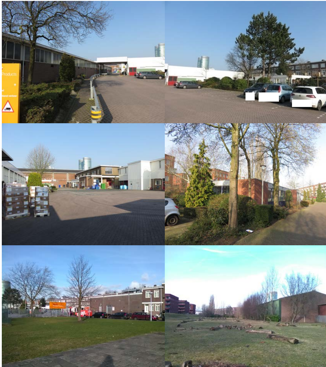
Figuur 2.2 Impressie van het plangebied met van linksboven naar rechtsonder: Overzicht van het terrein richting noord, overzicht van het terrein richting noordoost, noordelijk deel van het terrein, kantoorpand met groenstrook, braakliggend terrein zuidelijk deel, overzicht braakliggend terrein.
