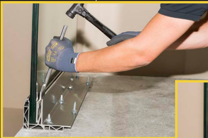
Aantikken van de klemstrip
