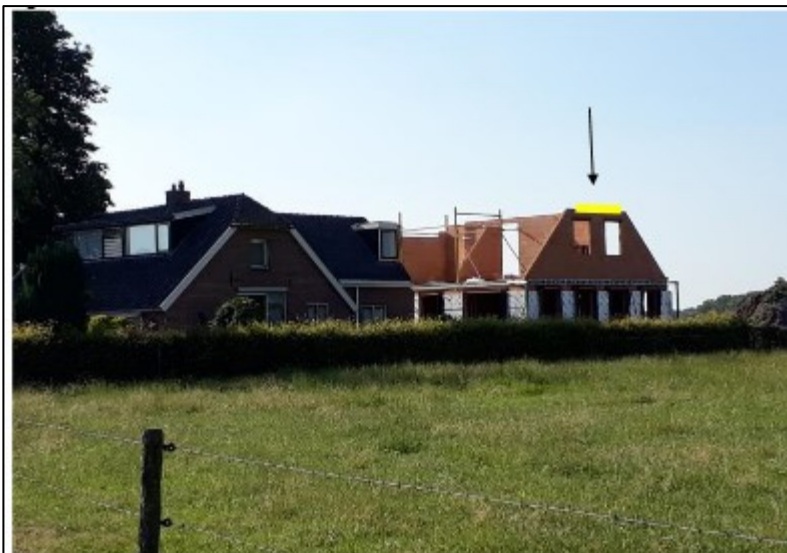
Figuur 2 Alternatieve voorzieningen, verhoogde vogelschroot op derde panlat aan de oost- en westgevel van de nieuwbouwwoning.
