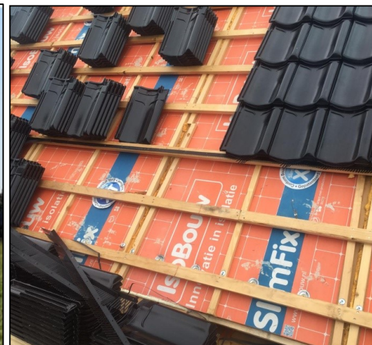
Figuur 2 Alternatieve voorzieningen, verhoogde vogelschroot op derde panlat aan de oost- en westgevel van de nieuwbouwwoning.
