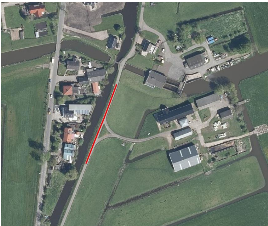
Figuur 4: Locatie zink in de weg t.p.v. Hogedijk 1, Aarlanderveen (lengte strekking circa 95 m)
