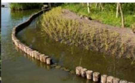
Soort beschoeiing: palenrijbeschoeiing functie: behoud doorstroomprofiel
