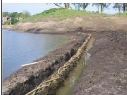
soort beschoeiing: paalwiepenbeschoeiing functie: tijdelijk behoud doorstroomprofiel
