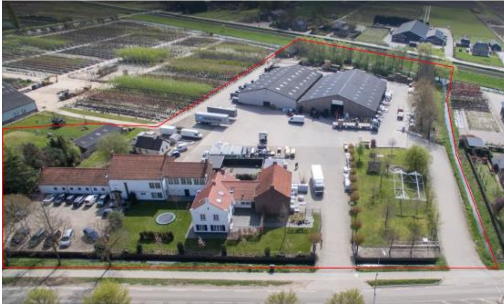
Figuur 1 Een overzichtsfoto van de planlocatie. Het nieuwe bouwvolume zal in plaats van de twee grote loodsen op de planlocatie gebouwd worden.
