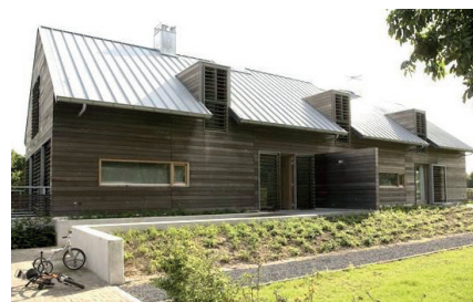
Drie identieke houten dakkapellen in een houten gevel (links)
