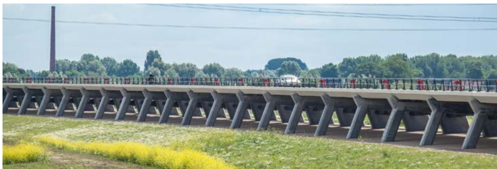
voorbeeld van een brug voor het doorlaten van water bij hoogwater (Veessen-Wapenveld)
