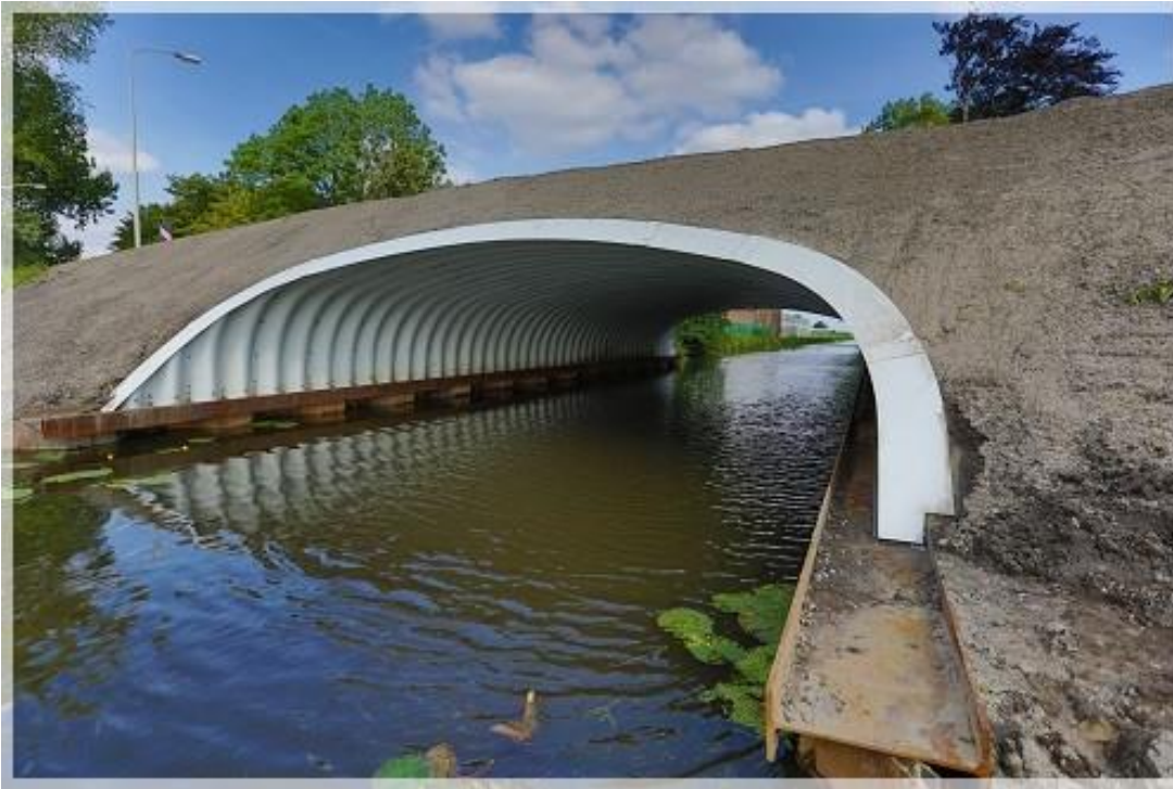
Figuur 4. Impressie Super Cor constructie.
