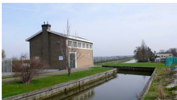
Berkel en Rodenrijs - gemaal aan de Noordeindseweg
