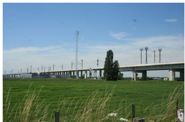
De opgetilde baan van de HSL.
