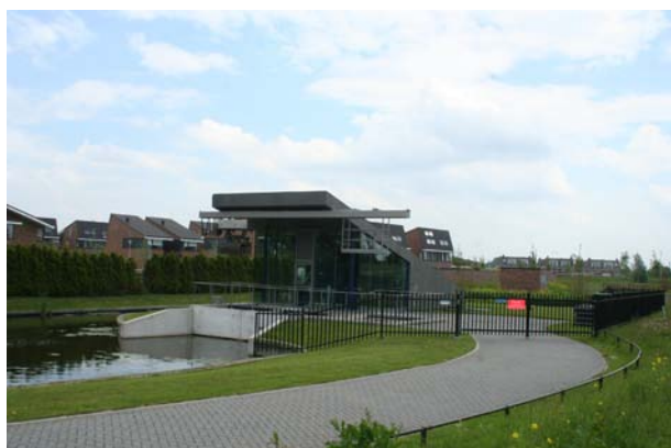
Het gemaal Meerpolder (2010) bij de Kruising Meerweg/Klapwijkseweg.
