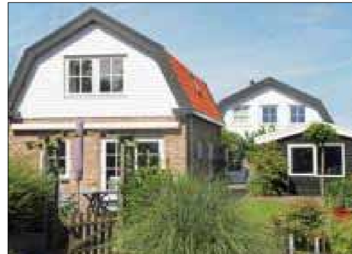
Verspringende bebouwing geeft doorkijkjes (3.3)
