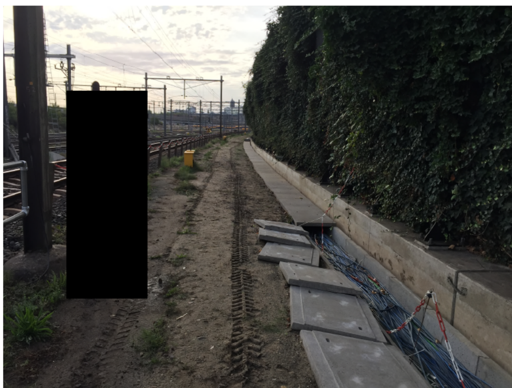
Figuur 11: Open koker langs geluidsscherm
