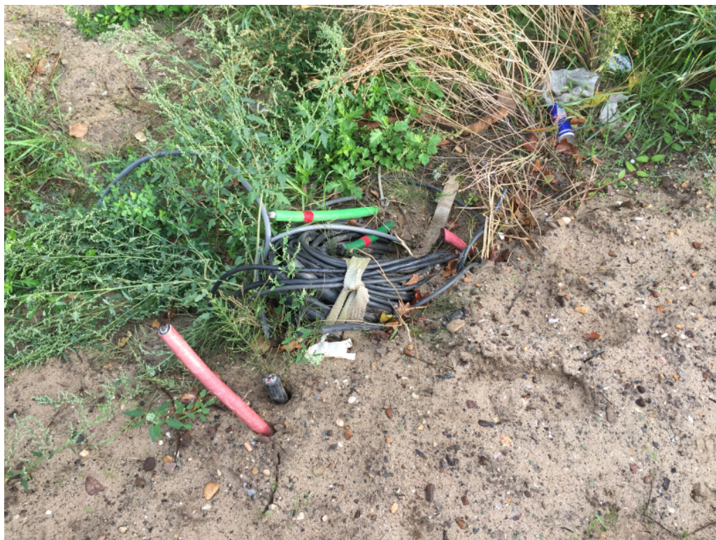
Figuur 19: Geknipte kabeleindes
