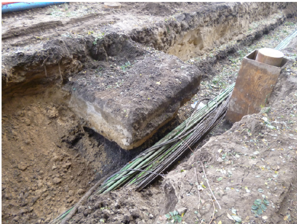
Figuur 2: Fundament onder RKH70
