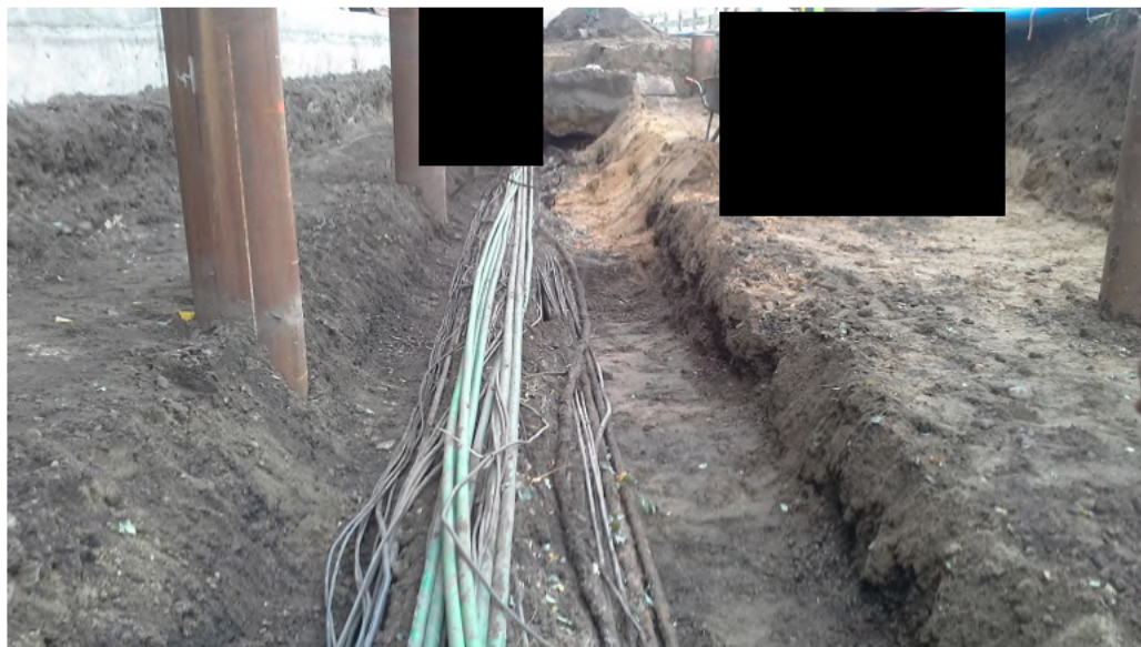
Figuur 6: Kabelbed op diepte
