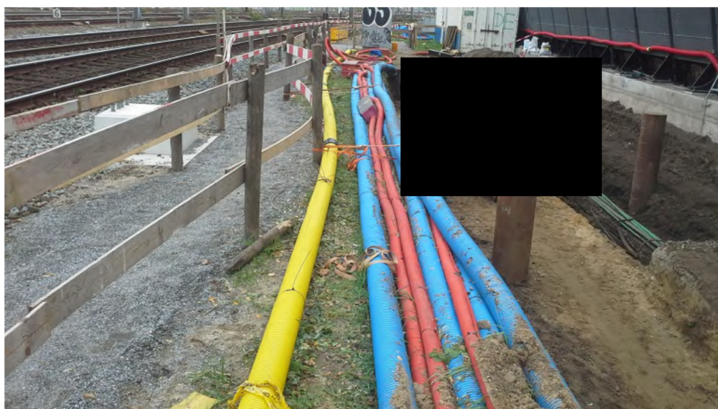
Figuur 5: Beschermbuisen langs het spoor
