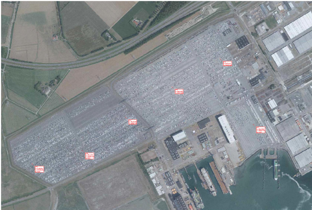
Figuur 1.3 Overzicht locaties windturbines C.RO
