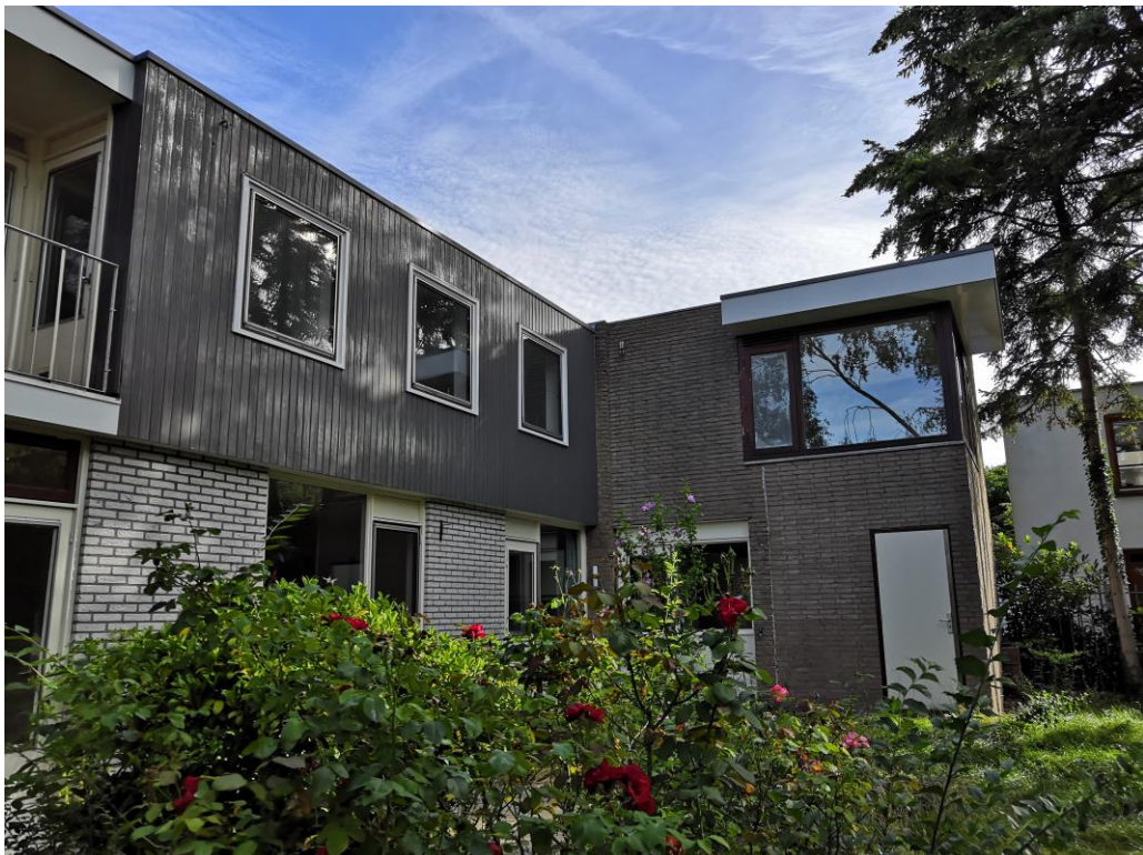
Figuur 2 De initiatiefnemer is voornemens de houten betimmering te verwijderen en de gevel te vernieuwen. Mogelijks wordt in de toekomst het plat bitumen dak vervangen.
