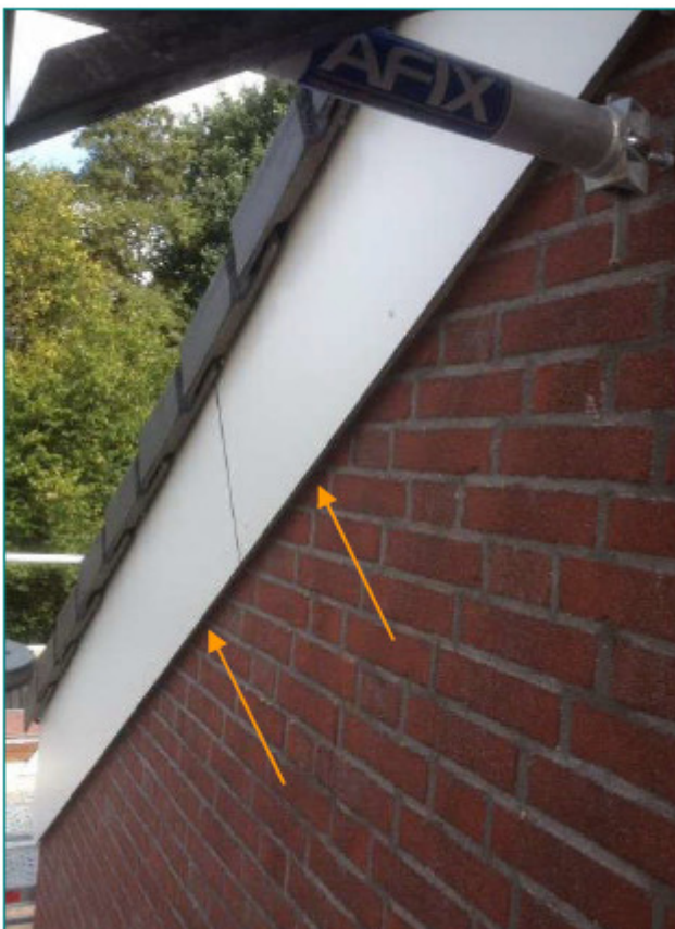
Figuur 5. Kopgevel met aangebrachte boeiboord. De pijlen geven enkele invliegopeningen voor vlermuizen weer in verschillende compartimenten.
