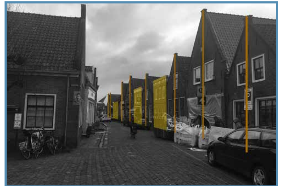
Ritme straatgevel Zuideinde: horizontale kroonlijsten en tuitgevels in 30/70 verhouding
