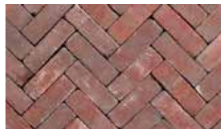
rijbaan gebakken klinker keperverband
