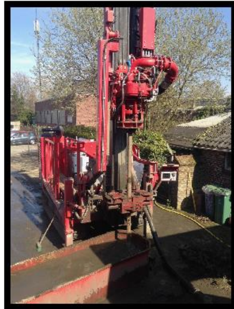
Afbeelding 1 & 2: Boorwagen opgesteld met bak voor losgekomen grond.
