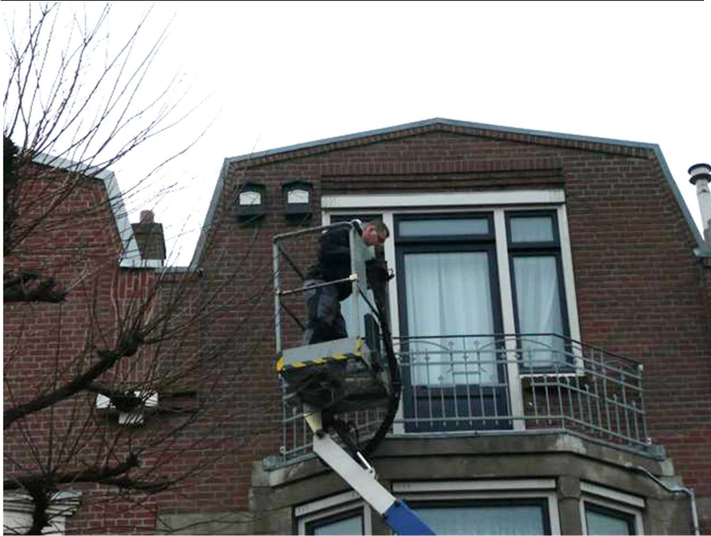
Figuur 1: montage van de vloermuiskasten
