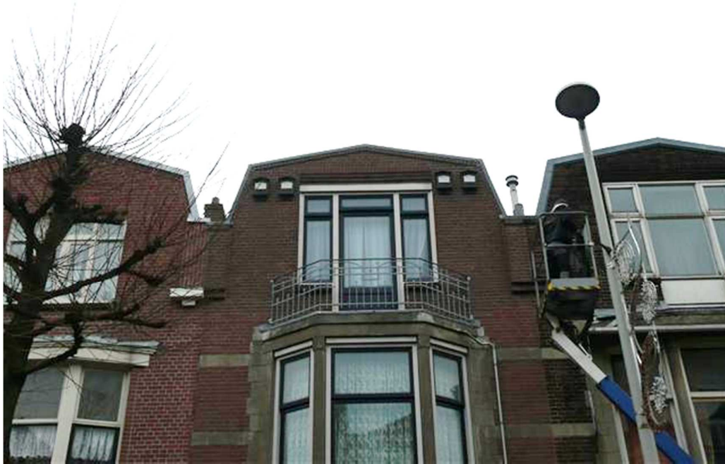
Figuur 2: eindsituatie na montage
