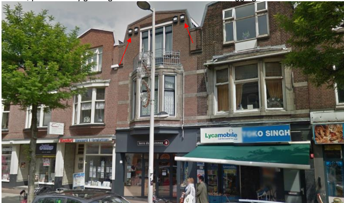
Foto 5, preventief opgehangen vleermuiskasten ter overbrugging in de Zwart Janstraat
