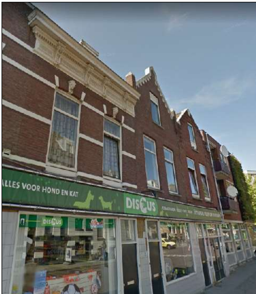
Afbeelding: Gevelaanzicht panden 3 e Pijnackerstraat met draai-kiepramen
