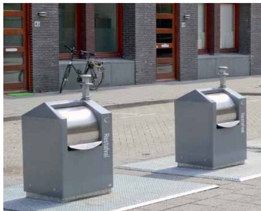
ondergrondse papier- en glascontainer
