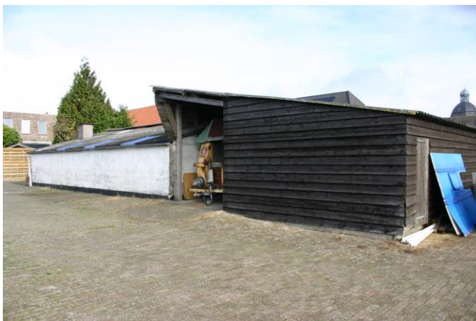
Figuur 4.2.2. De voormalige stallen zijn volledig enkelwandig.
