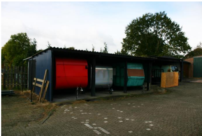
Figuur 4.2.1. De open schuren zijn volledig enkelwandig.
