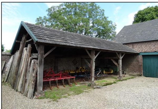
Figuur 7. Aanzicht open schuur voor opslag werktuigen
