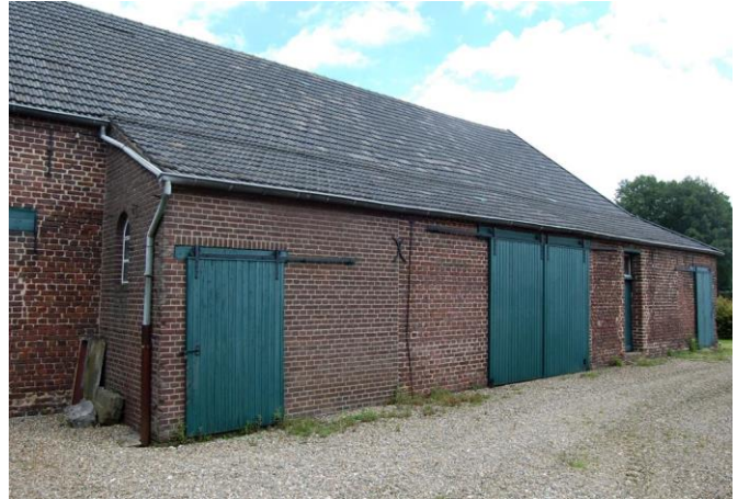
Afbeeldingen 8 en 9. Links de oostelijke kopgevel van de schuur, met bouwsporen van het voormalige woonhuis en de in deze gevel hergebruikte ankers die eerst in de naar het zuiden gerichte voorgevel van Huis Steenhagen waren gebruikt. Rechts de naar het erf gerichte zuidgevel van de schuur. Behalve oud metselwerk is hier weinig van de oorspronkelijke gevel bewaard gebleven. (Foto's Thijs Pubben, 4 juli 2016.)
