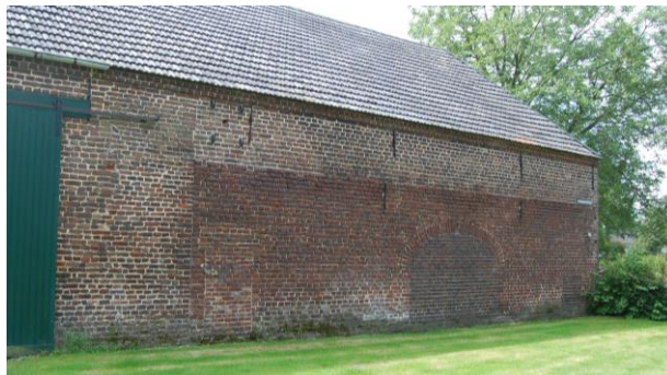
Afbeelding 10. De noordgevel van het schuurgebouw van de boerderij Steinhagen. Duidelijk zichtbaar zijn de gevel van het vroegere voorname huis (links), de muur van de later aangebouwde stal met de dichtgemetselde stalpoort voor de mestkar en het nieuwere metselwerk uit oude stenen, om de stal op te hogen toen die tot schuur werd herbestemd. (Foto Thijs Pubben, 4 juli 2016.)
