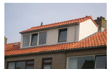
Nokverhoging alleen door doortrekken van voordakvlak waardoor de nok verhoogd en naar achter verschuift
