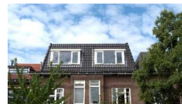
Dakopbouw op plat dak met een kap. Eenheid van pand blijft gehandhaafd.
