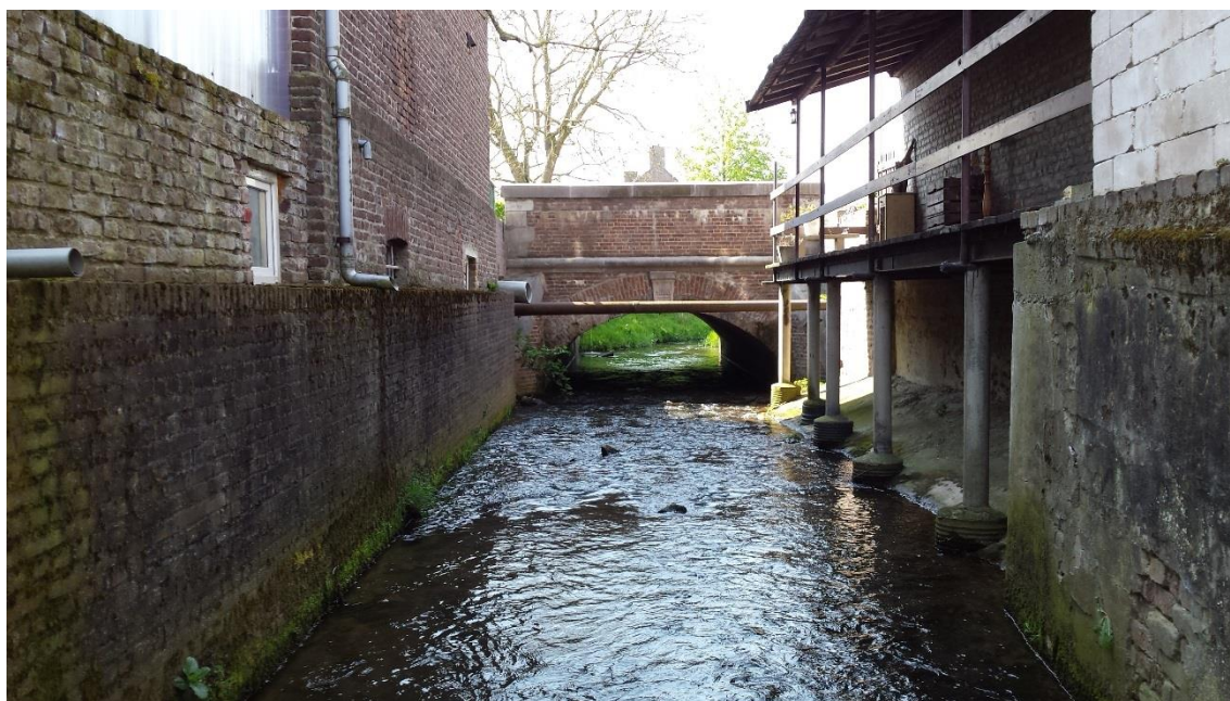
Figuur 7 Selzerbeek tussen de twee gebouwen en onderdoorgang bij de rijksweg N278.
