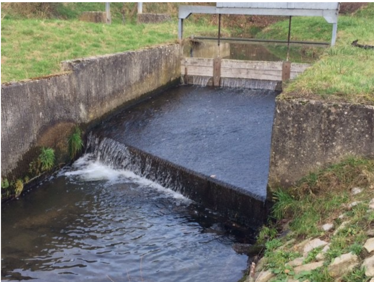
Foto: Bestaand verdeelwerk (met bodemval) welke de watertoevoer regelt naar de Wittemermolen.
