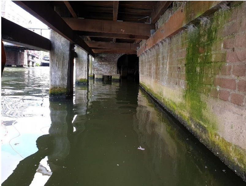
Figuur 6, situatie onder steiger
