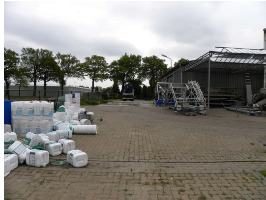
Ontsluiting naar Hofweg, gezien van achterste deel van perceel
