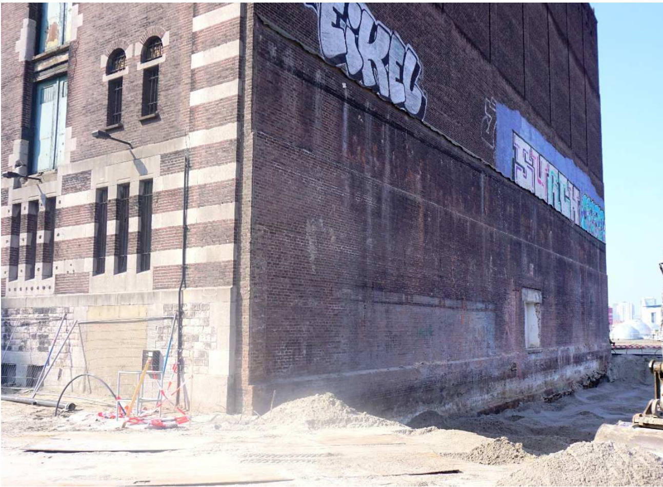
Overzichtsfoto Huidige toestand Oostgevel Santos
