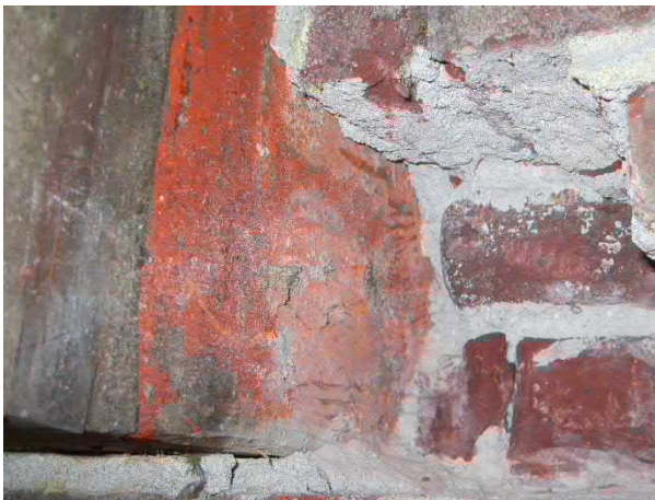
Figuur 4.14: Opengewerkte balkkop
