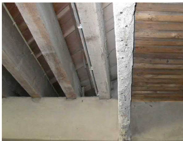
Figuur 4.23: Scheiding open en afgetimmerde deel
