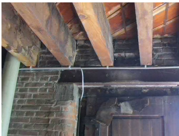
Figuur 4.22: Locatie opgewerkte balkkoppen
