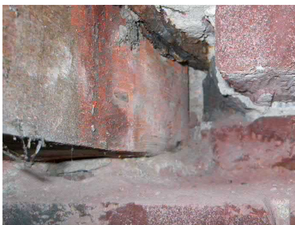
Figuur 4.8: Opengewerkte balkkop
