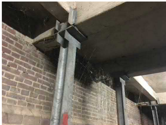
Foto Stalen kolommen langs gevel kelder
