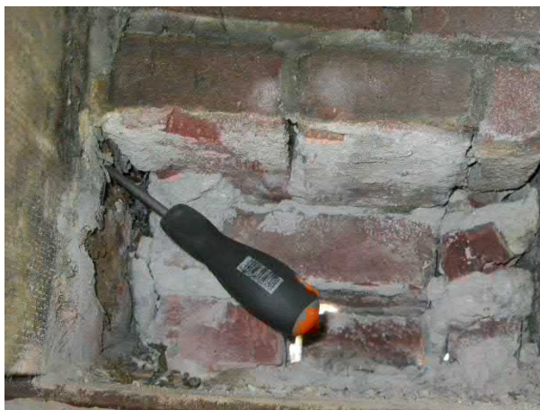
Figuur 4.20: Aantasting balk 61
