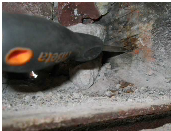
Figuur 4.21: Aantasting balk 62
