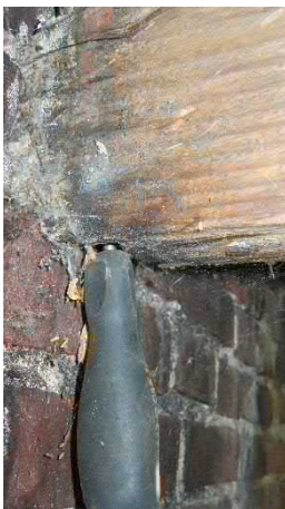
Figuur 4.5: Ernstige aantasting balk 24 voorzijde
