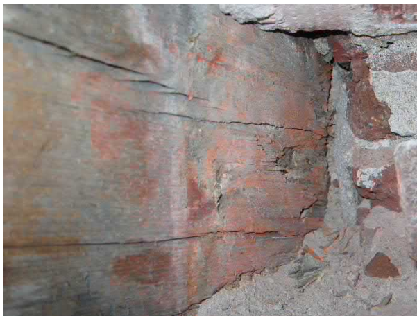
Figuur 4.1: Opengewerkte balkkop
