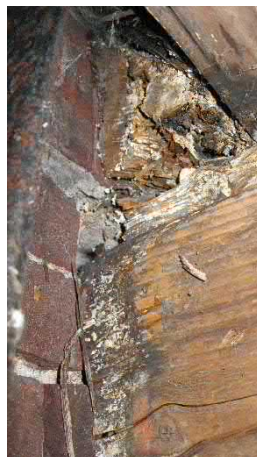
Figuur 4.6: Ernstige aantasting balk 24 voorzijde
