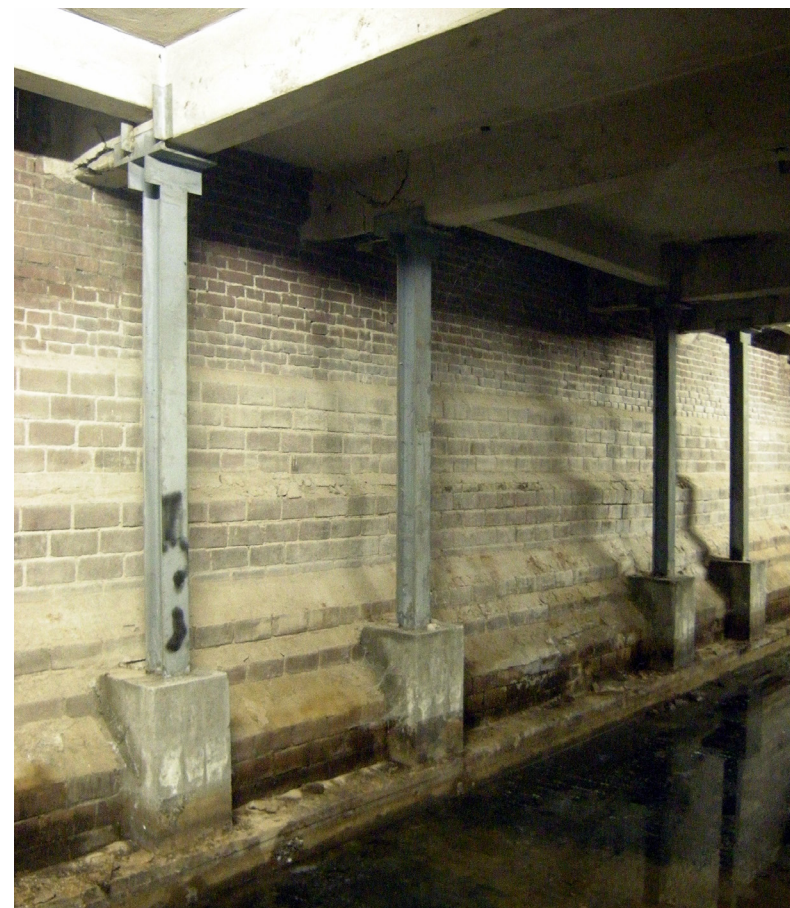
Stempelconstructie kelder
