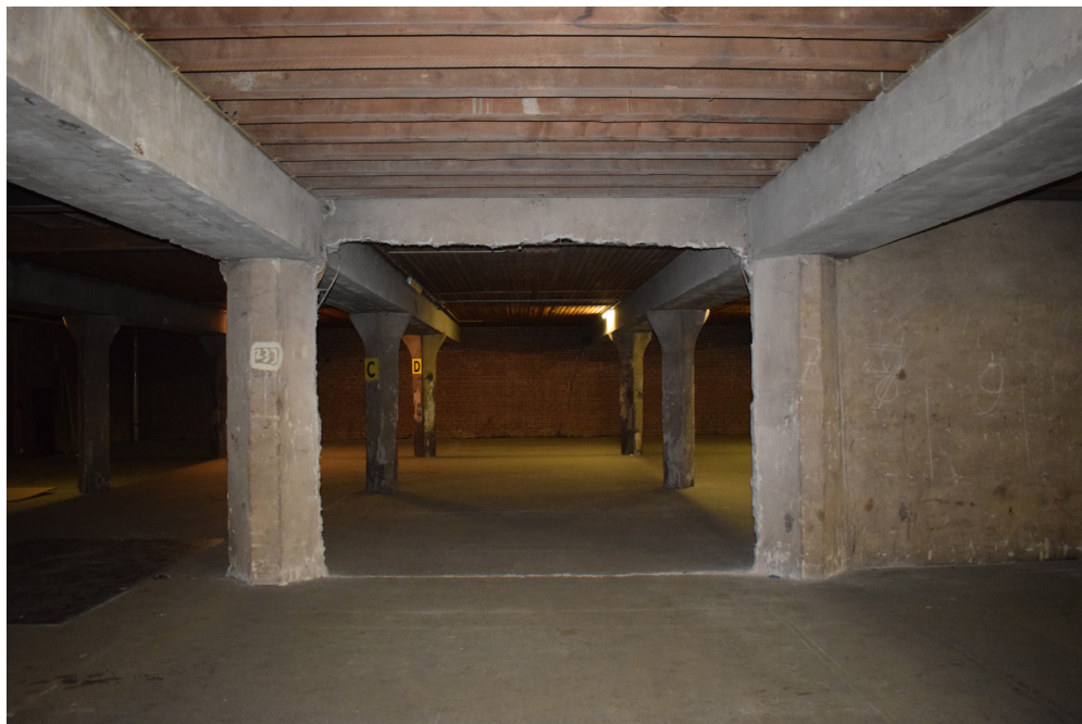
Reeds gesloopte Hennebique-wand
