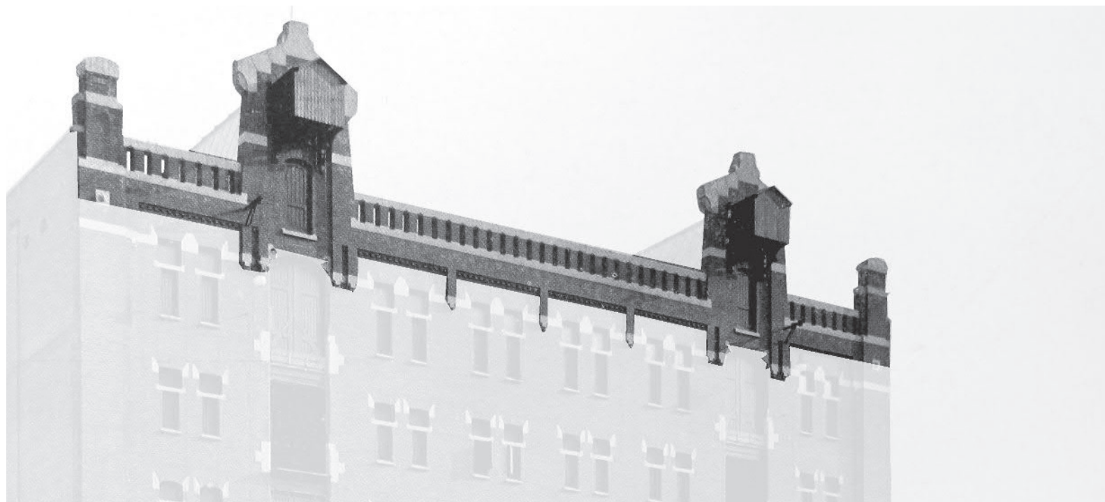
Originele dakrand met lierhuisjes 1917
