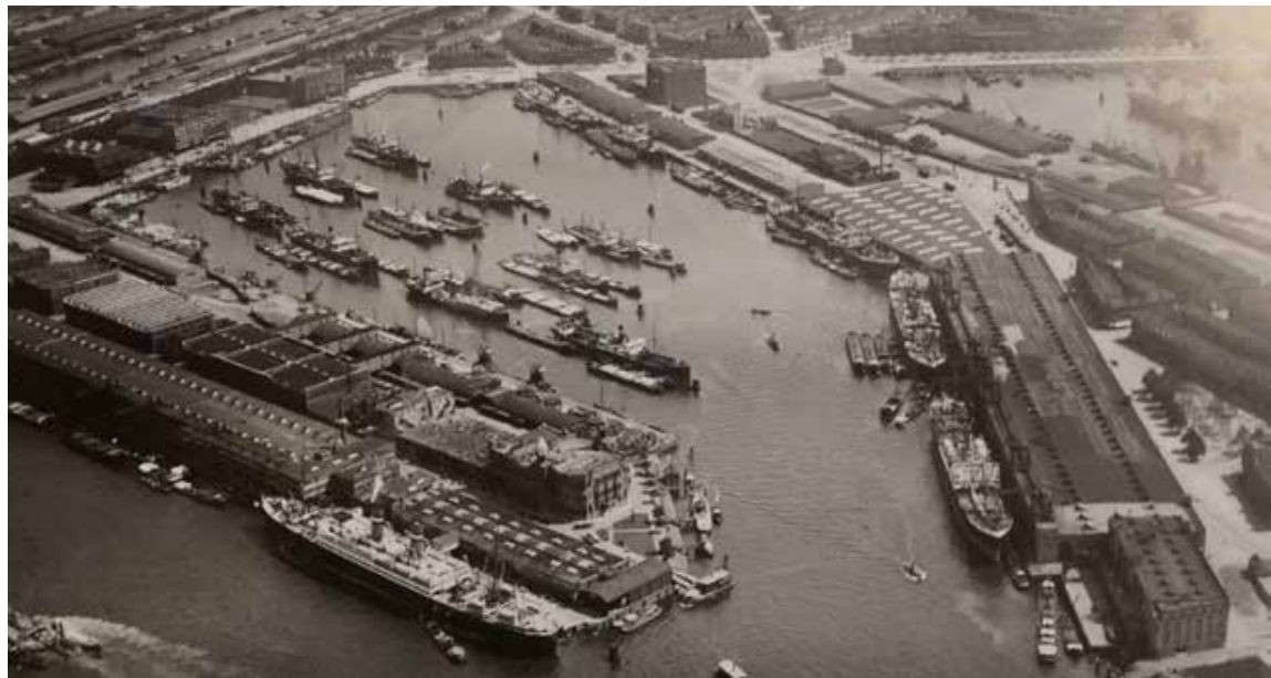
Luchtfoto oorspronkelijke situatie Rijnhaven
