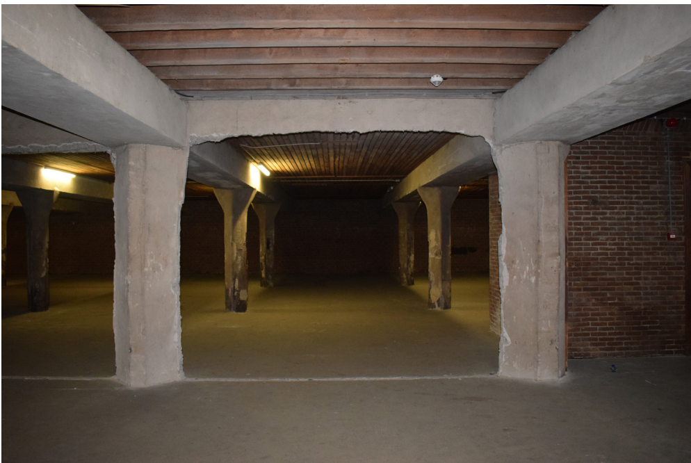
Reeds gesloopte Hennebique-wand
