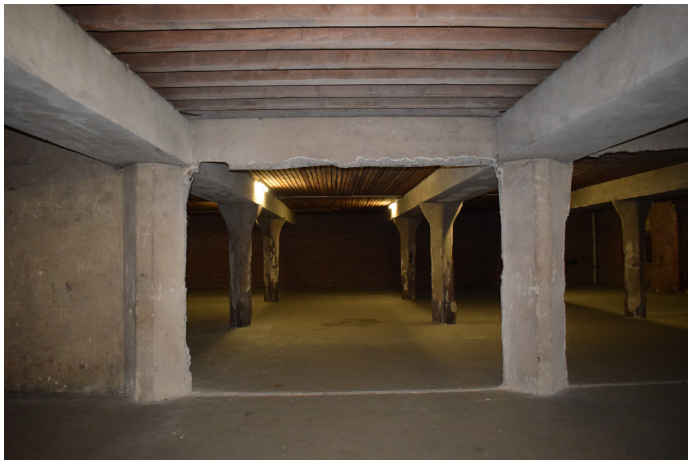
Reeds gesloopte Hennebique-wand
