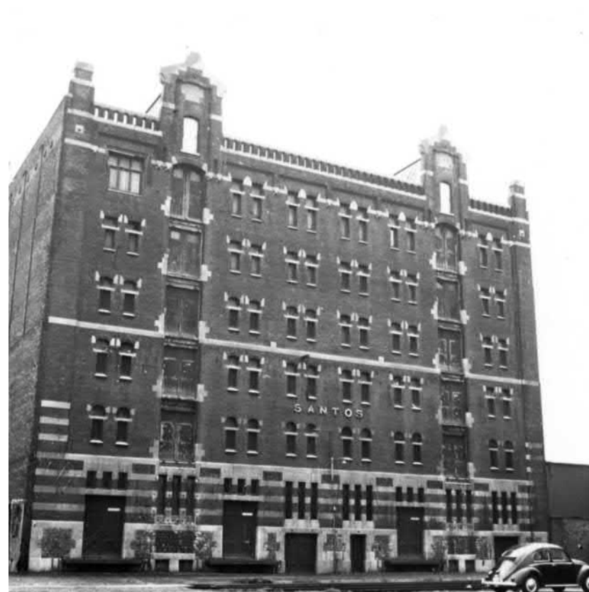
Zuidgevel (Brede Hilledijk)
