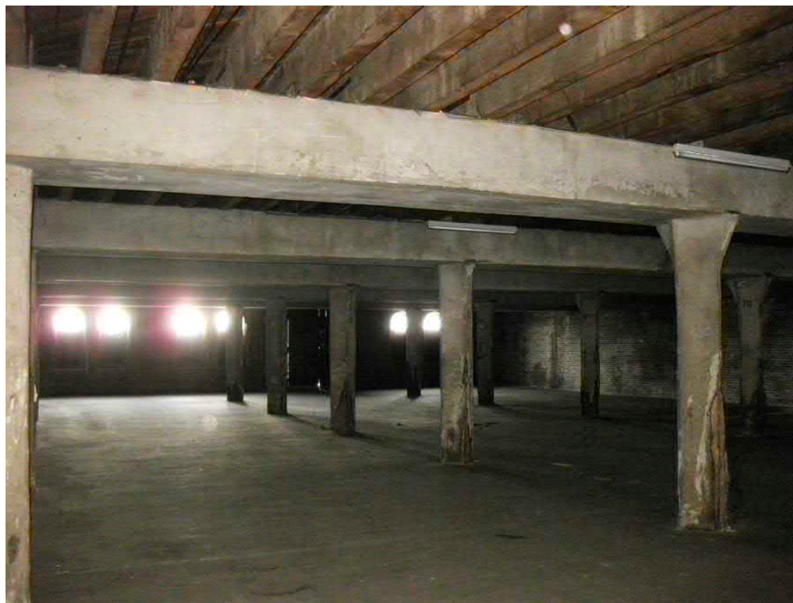
De opslaghal op de eerste verdieping met brandwerend ingepakte kolommen
