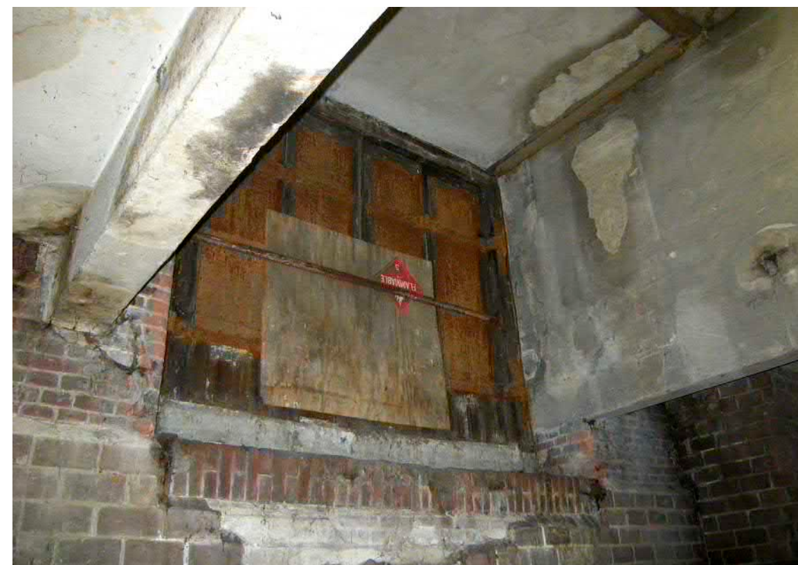
Transportluik op straatniveau
