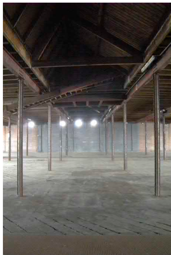
Dichtgezette shed (5e verdieping)
