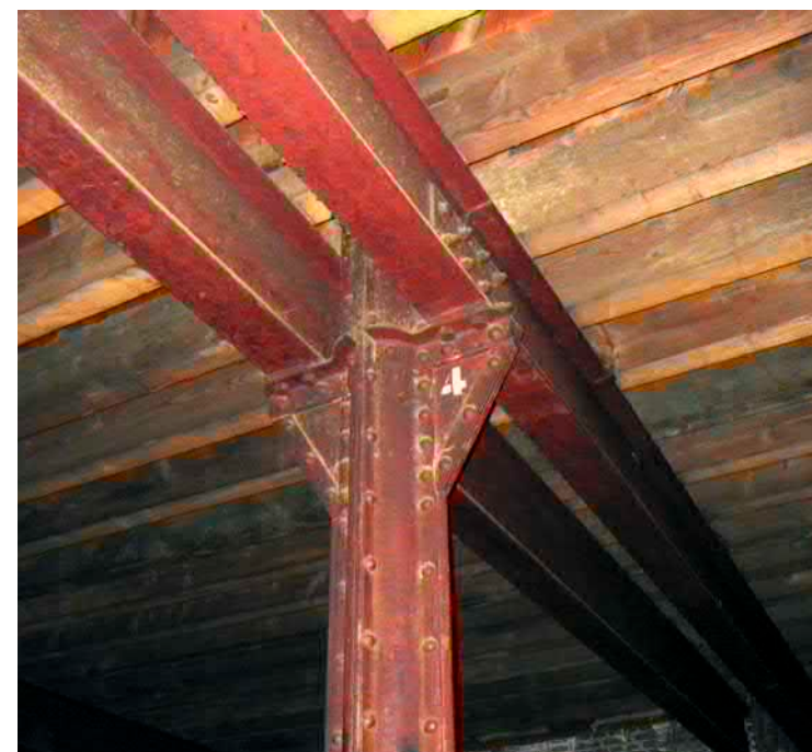
Constructie op de 4e verdieping: houten balken op dubbele ijzeren liggers en ijzeren kolommen
