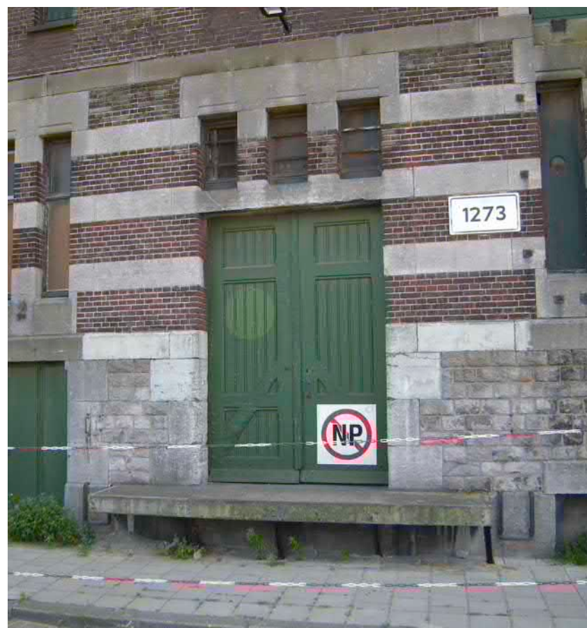
Links: en rechts: de laaddeuren en de laadbalkons
