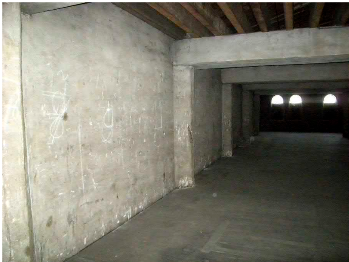
De opslaghal op de eerste verdieping, met de hennebiquewand in het midden
