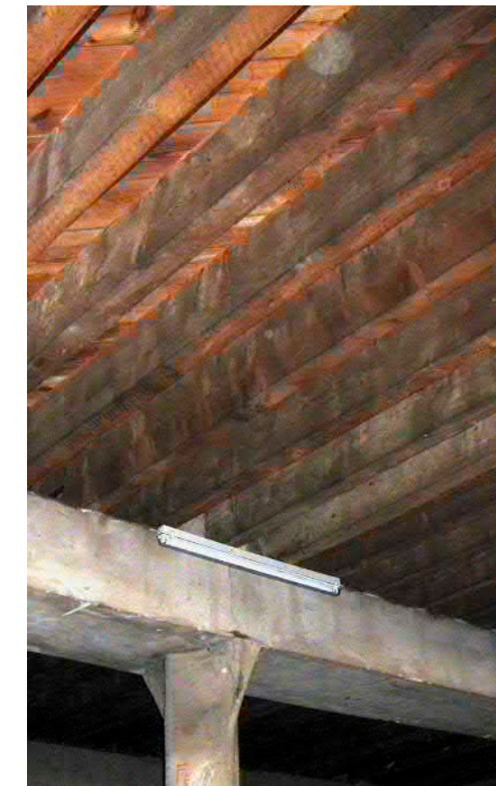
De houten vloerplanken zijn diagonaal op de balken aangebracht, met uitzondering van de dakvloer
