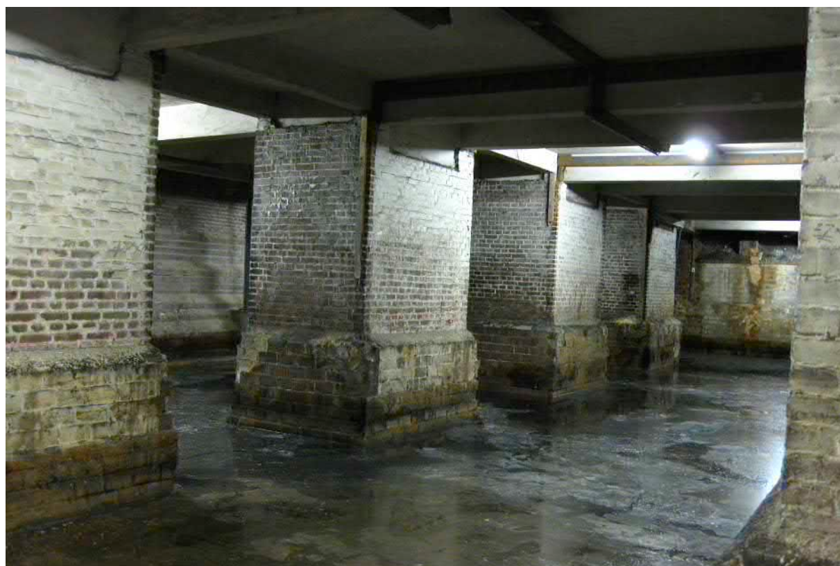
Kelderverdieping met grote gemetselde funderingspoeren
