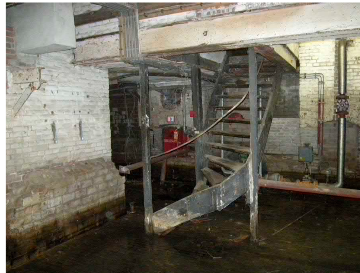
De kelder is vanuit de entreehal met een open trap te bereiken
