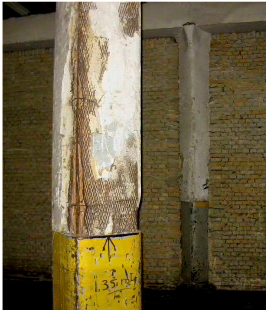
Kolom op de parterre, afgewerkt met gaaswapening en stuc/cement. Op de achtergrond een latere metselwerk-wand, waar oorspronkelijk een Hennebiquewand stond.
