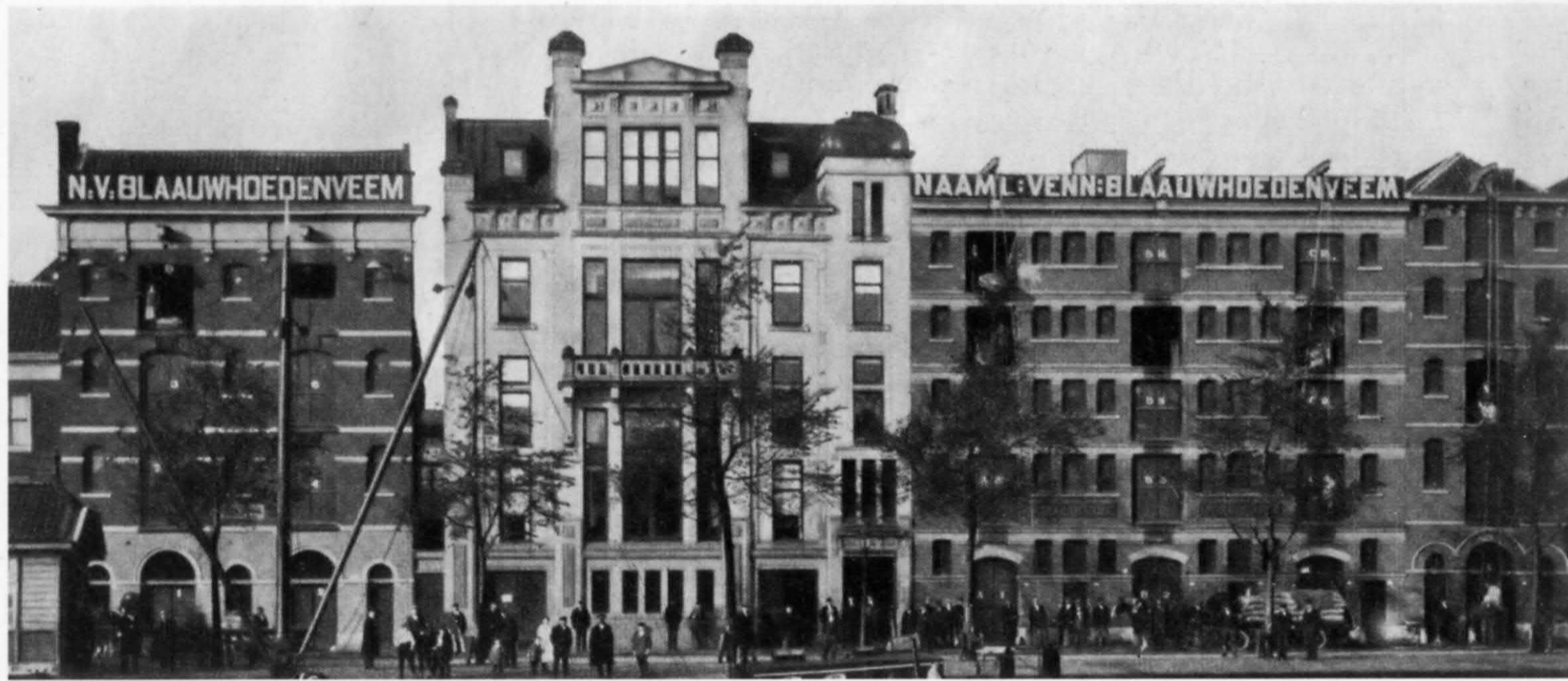
Kantoor NV Blaauwhoedenveem aan de Leuehaven, van architect J.J. Kanter..<Archief Koninklijke Vopak B.V.>
