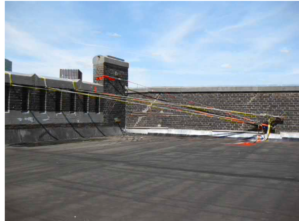
Links: de attiek vanaf het dak gezien, met links op de foto de aanheling ter plaatse van de afgebroken lierhuisgevel.
