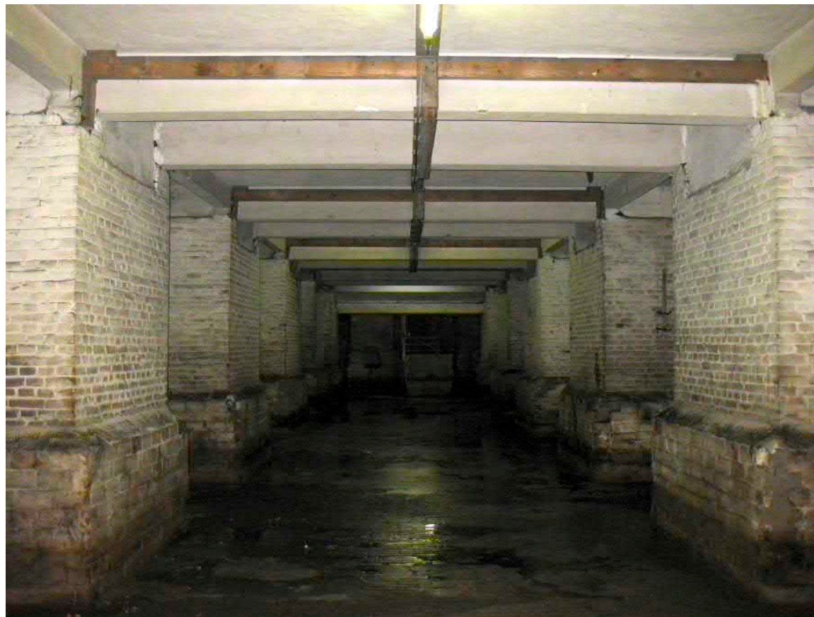
Hoofddraagconstructie op kelderniveau: funderingspoeren die de Hennebiquevloer van de parterre dragen
