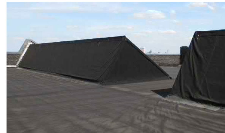
5e verdieping, dakconstructie ter plaatse van de dichtgezette sheds, met in het midden een staal-constructie ten behoeve van het doorzetten van de dakvloer.
