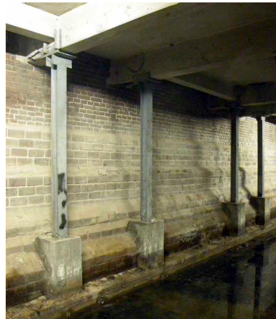
Stempelconstructie tegen de zijwand van de kelder, ter ondersteuning van de betonnen vloerbalken.
