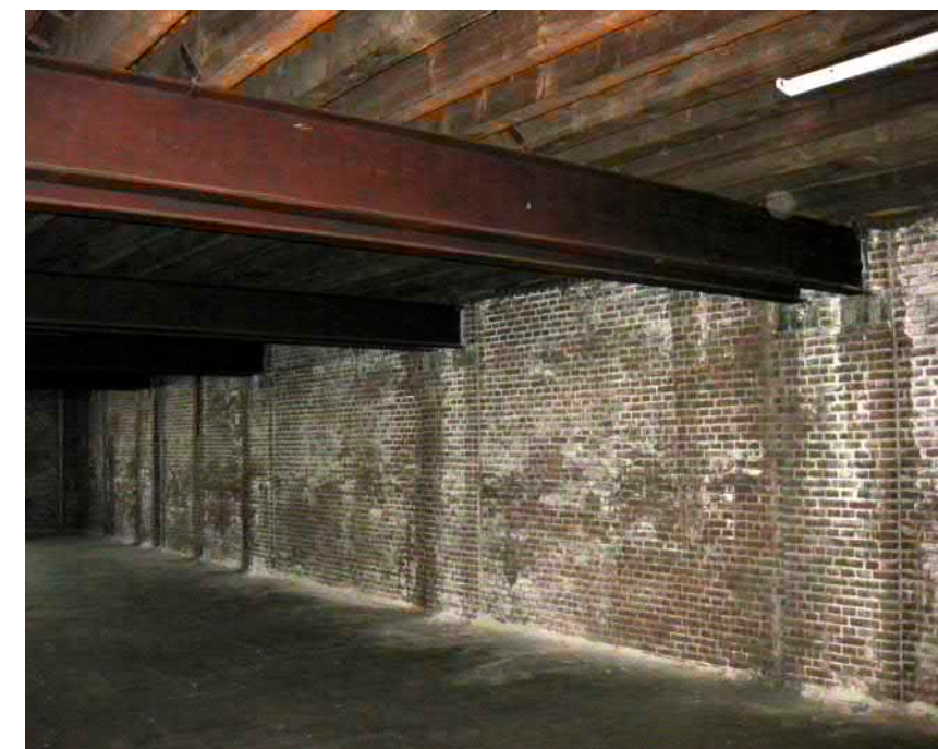
Constructie op de 4e verdieping: ijzeren liggers opgelegd op de gemetselde penanten in de zijgevel
