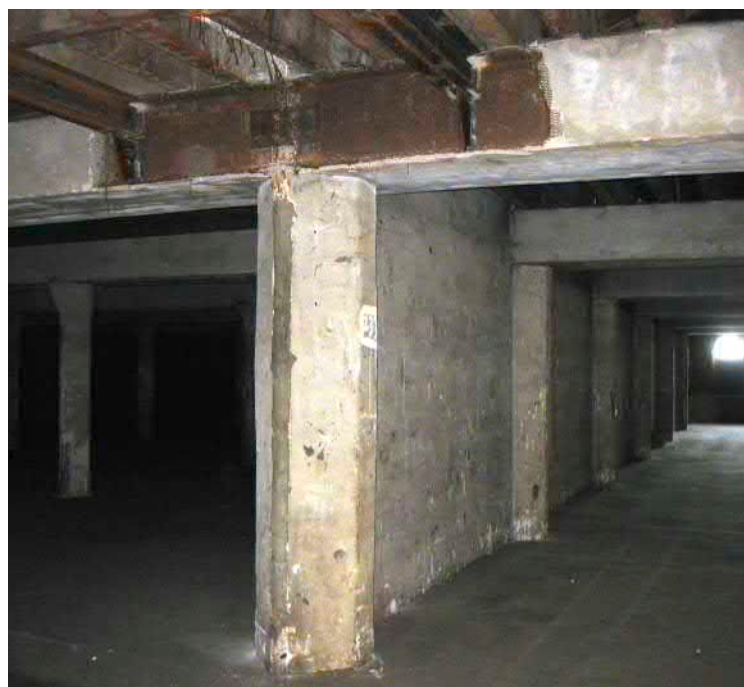
Hennebiquewand op de 1e verdieping
