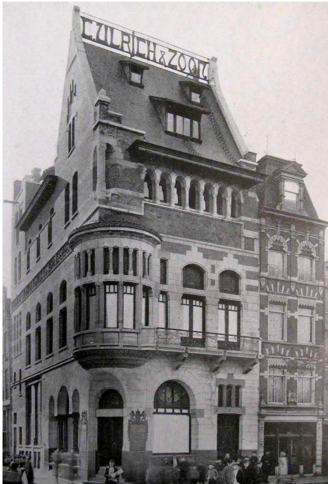
Winkelhuis Ulrich en Zn, Leuvehaven Rotterdam, Architect J.P. Stok 1898 <Graafland 1917>
