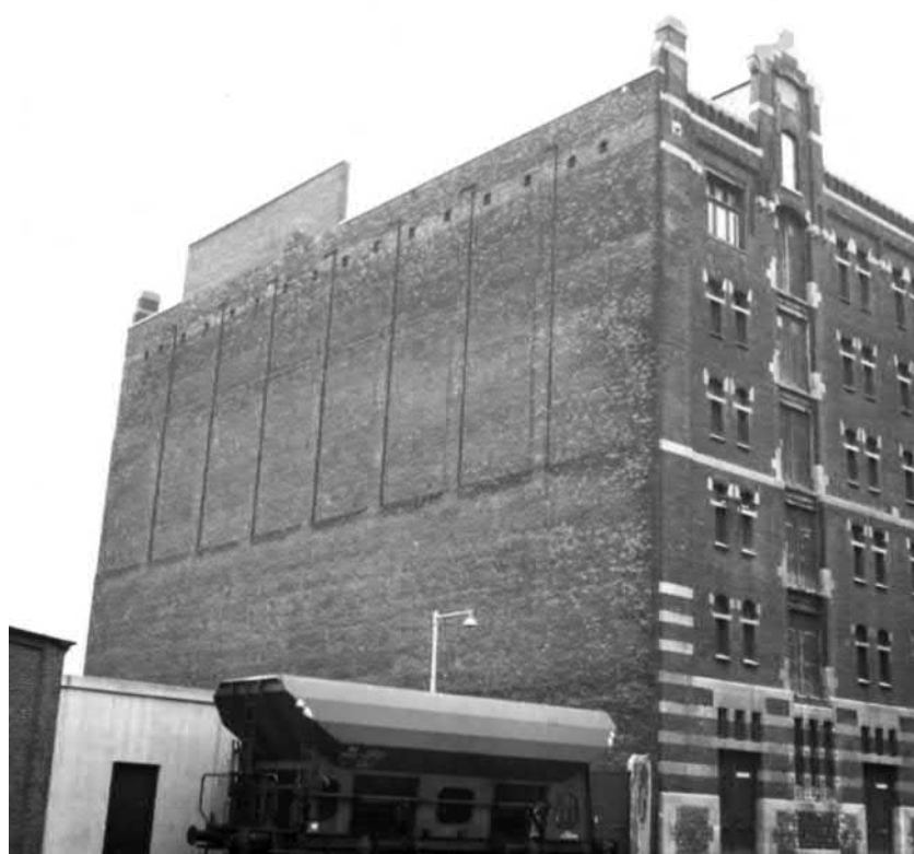
Westgevel (gezien vanaf de Brede Hilledijk)
