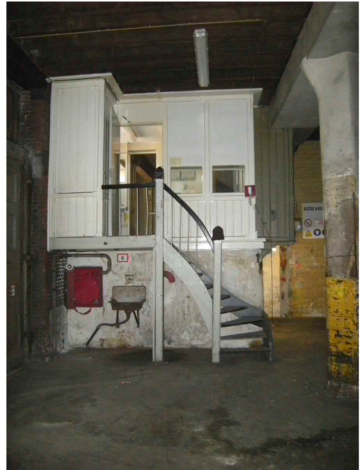
Het baaskantoortje, tevens doorgang van de entreehal naar de parterre
