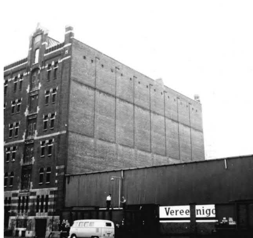
Oostgevel (gezien vanaf de Brede Hilledijk)
