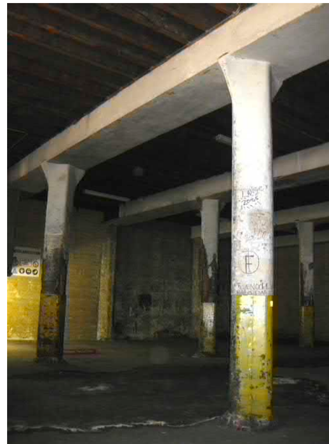
Hoofddraagconstructie op parterreniveau
