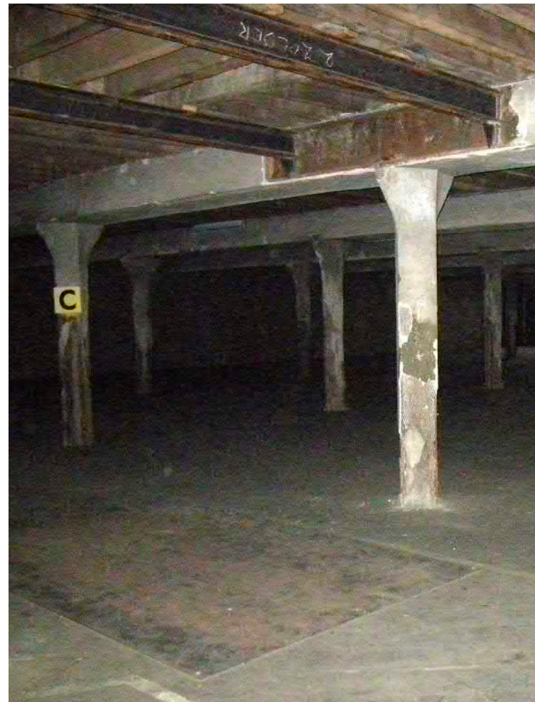
Constructie t.p.v. de oude liftschacht, waarbij de vloer is dichtgezet met houten balken die rusten op de nieuw aangebrachten stalen liggers. De sparing in de vloer is afgedekt met een stalen plaat.
