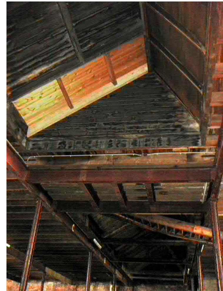
5e verdieping, dakconstructie ter plaatse van de dichtgezette sheds, met in het midden een staal-constructie ten behoeve van het doorzetten van de dakvloer.
