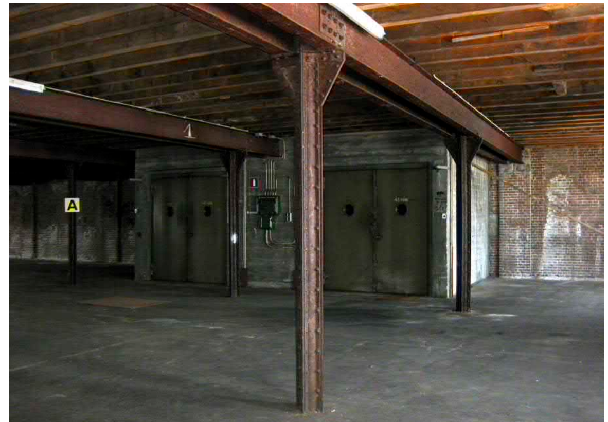
De nieuwe liftschacht ter plaatse van de westgevel, hier op de 4e verdieping
