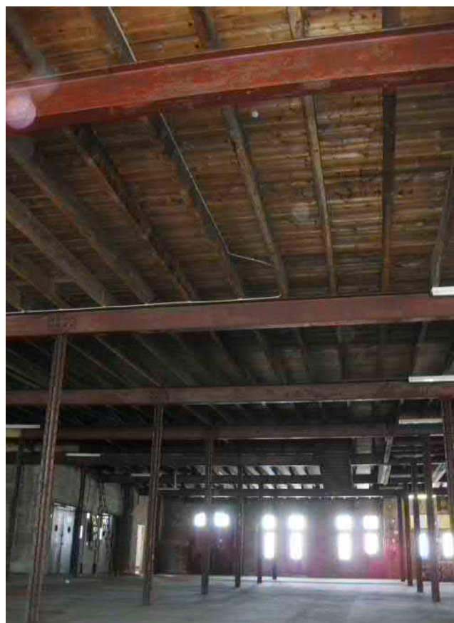
Opslaghal en dakvloer (5e verdieping)
