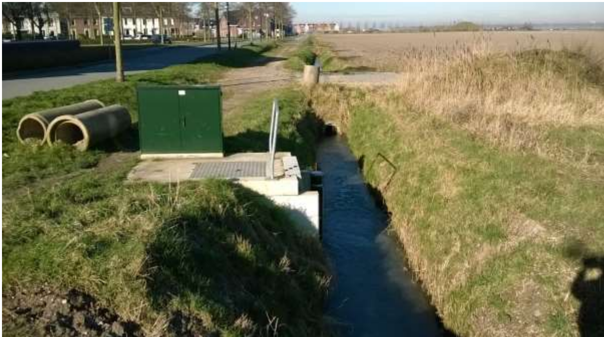
Figuur 2: De te verruimen watergang W04565, de te vervangen duiker en pomp Singelkade.
