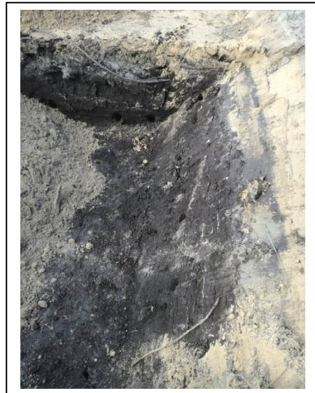
Ontgraving met links aangevoerd zand
