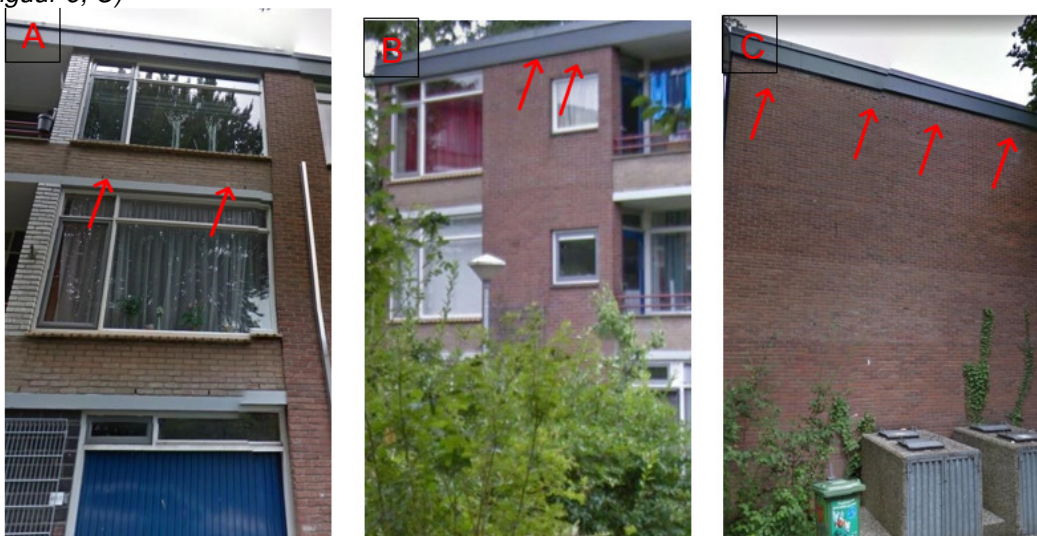
Figuur 6: Ligging van de aan te brengen vleermuistunnels (zie ook figuur 7) onder elk woningraam op de 3 de woonlaag 2 (Figuur 6, A), op de 3 de woonlaag boven het kleine raam (Figuur 6, B) en aan de beide kopse kanten van de portiekflats bovenaan vlak bij de daklijst (Figuur 6, C)
