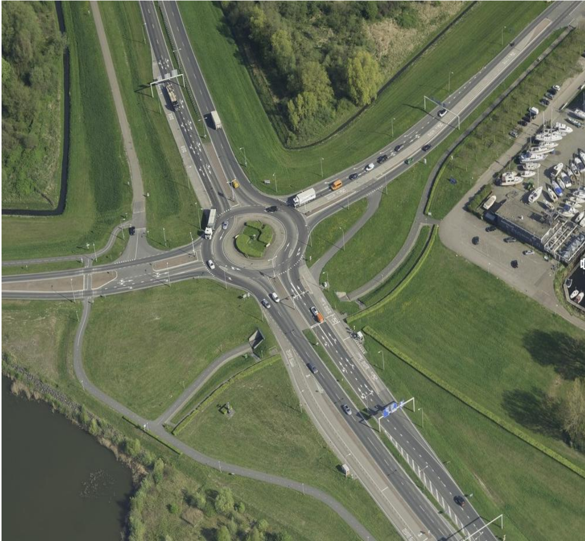
Figuur 2.2 Luchtfoto bestaande situatie (Bron: Cyclomedia Streetsmart)
