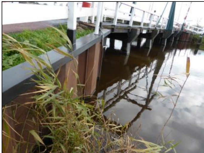
Afbeelding 3. Beschoeiing met rietoever buiten brugbeschoeiing
