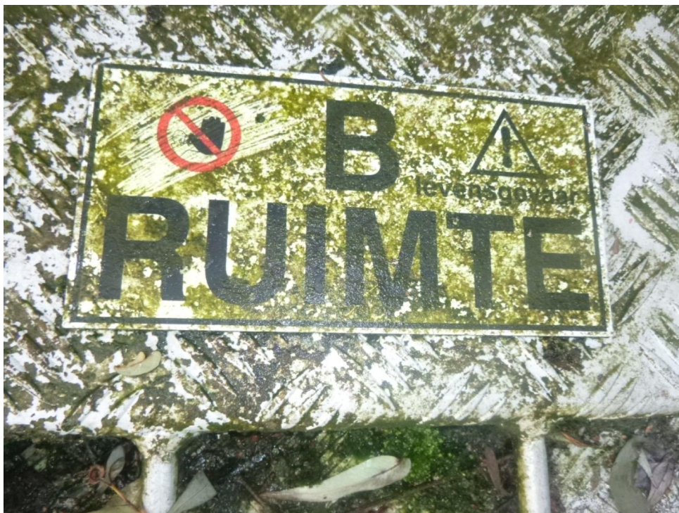
Foto 5: Zicht op een niet toegankelijke ruimte achter het gemaal.
