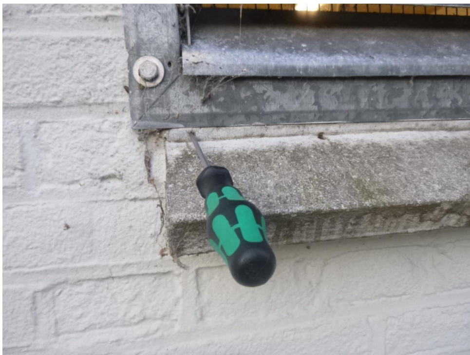
Foto 6: Zicht op geschouwde niet asbestverdachte kit ter plaatse van een rooster.
