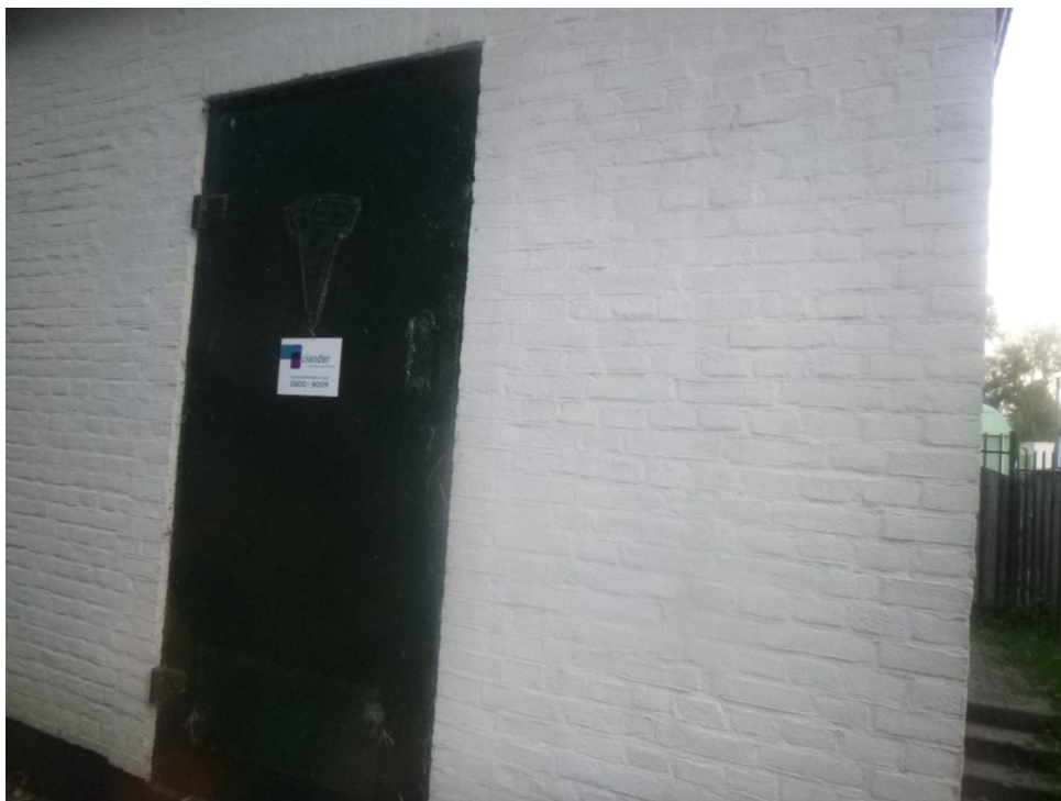
Foto 1: Zicht op de niet toegankelijke ruimte van de netbeheerder.
