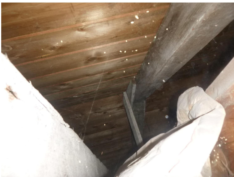
Foto 4: Zicht op een deel van de kapconstructie boven het plafond.
