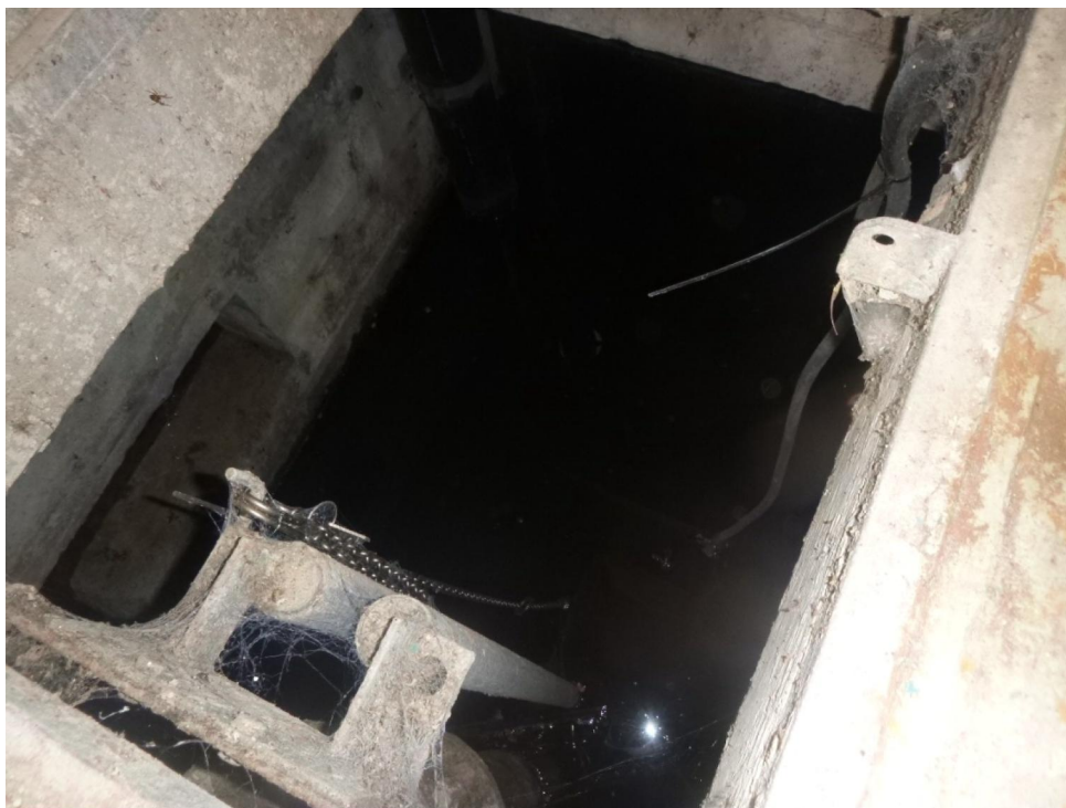
Foto 7: Zicht op een A-ruimte onder het gemaal (niet toegankelijk, besloten ruimte / in bedrijf, vol water).
