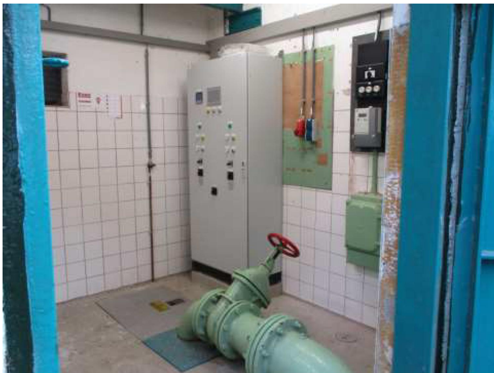
Foto 1: Zicht op het interieur van het gemaal.
