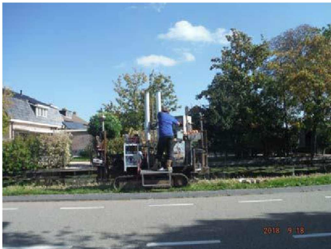
Afbeelding 6.1: grondmechanisch onderzoek in uitvoering aan de Wagendijk
