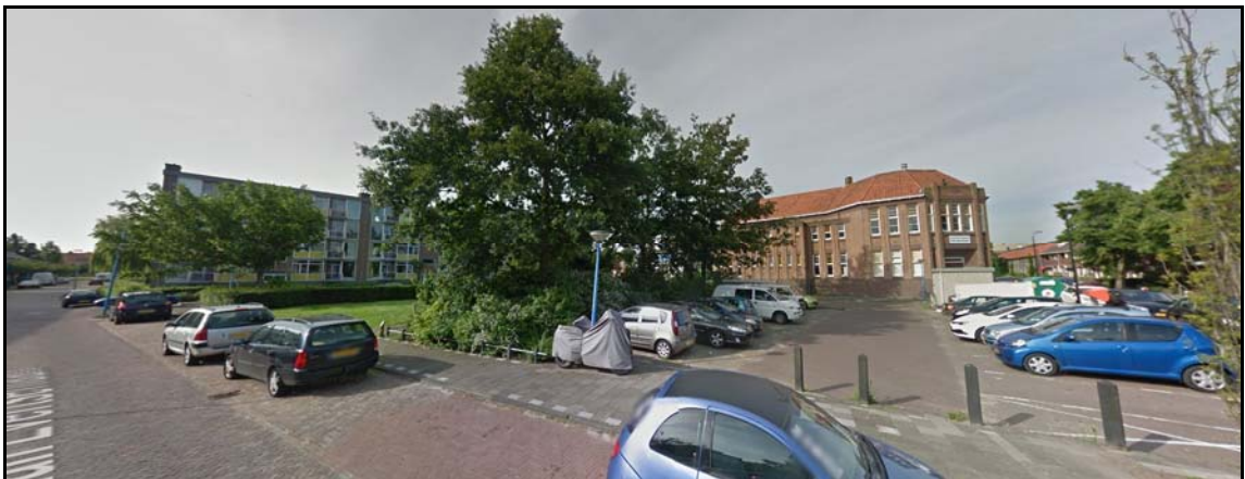
Afbeelding 4: Huidige inrichting Fenacoliussplein, met rechts op de achtergrond het monumentale schoolgebouw.
