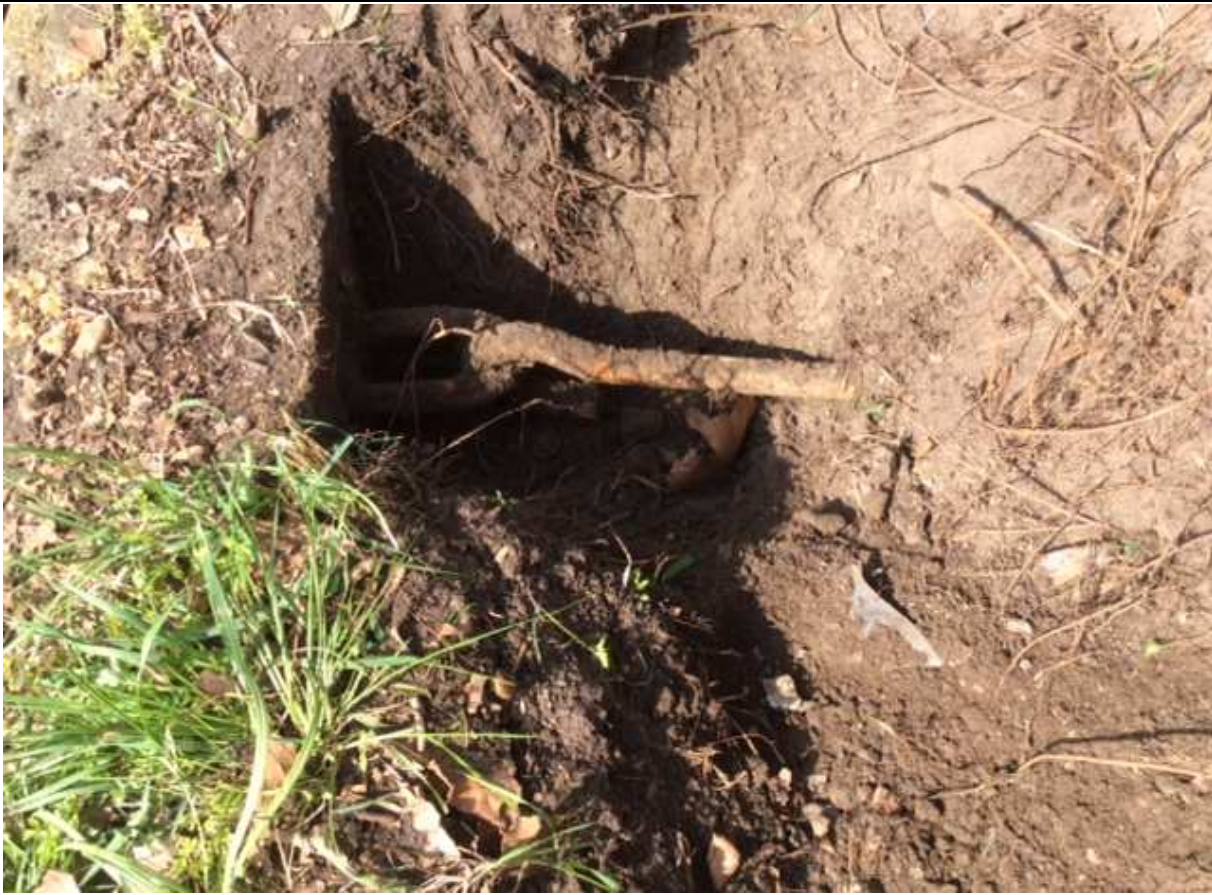
Figuur 4 Detail grondanker aan betonnen deksloof
