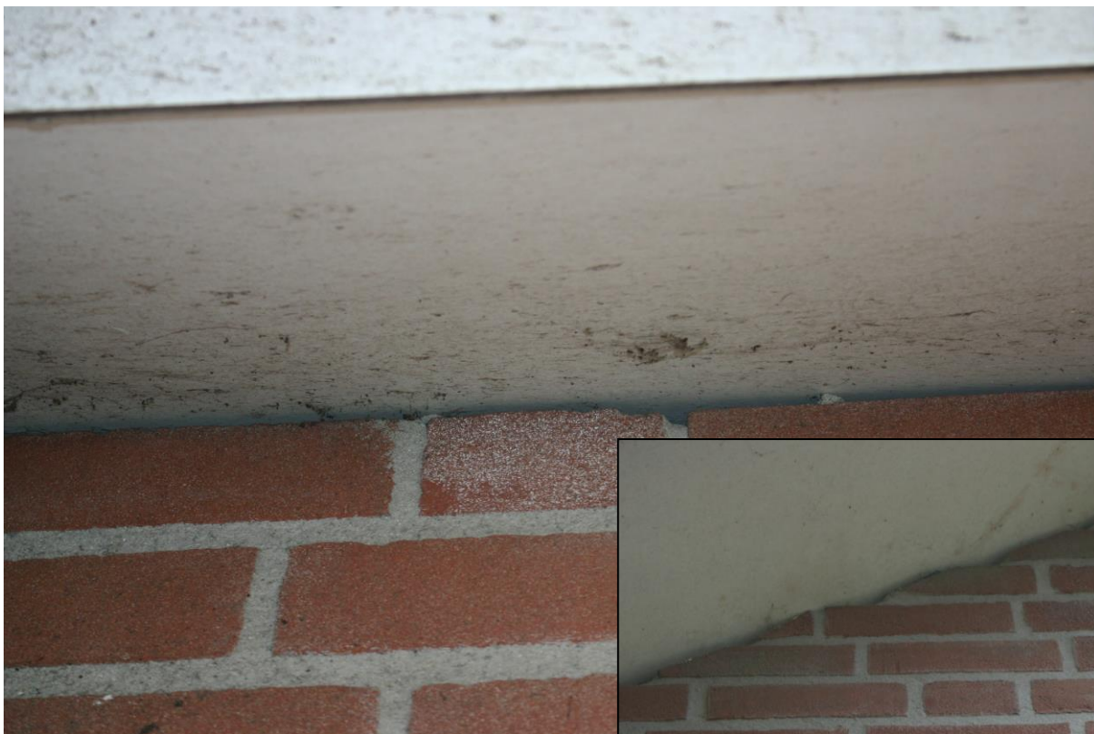
Figuur 4.2. Tussen de dakbetimmering en de gevels zit een ruimte waardoor de achterliggende spouw bereikbaar is voor vleermuizen.
