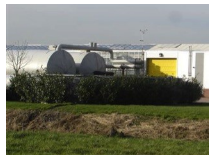
De silo verscholen achter beplanting
