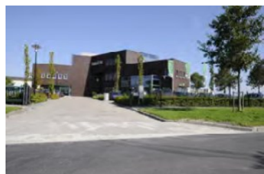
Recente bouw met een representatieve architectuur
