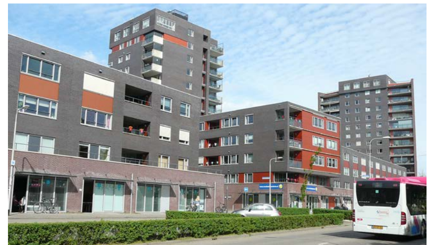
> Bestaande hoogbouw van de Waalhaeve aan de Weurtseweg
