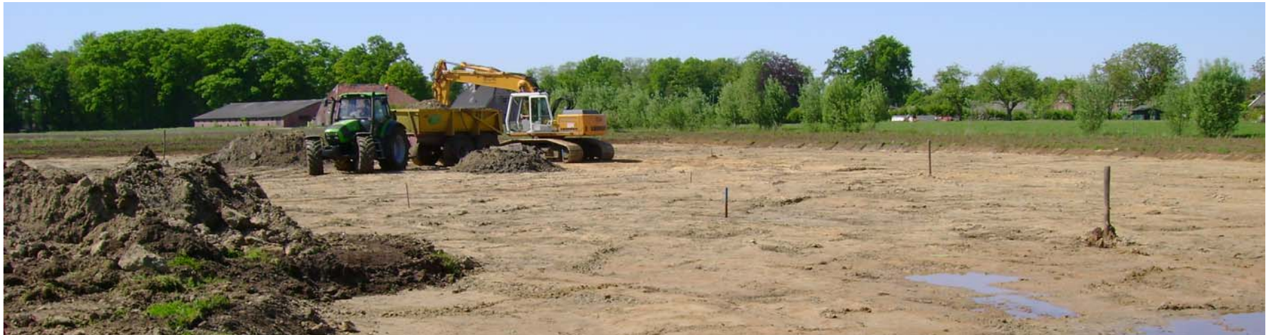
Figuur 4.6. Foto van ontgrondingswerkzaamheden waarbij de fosforrijke toplaag van voormalige landbouwpercelen wordt verwijderd om de ontwikkeling van soortenrijke, grondwater gevoede, voedselarme natuur mogelijk te maken. Foto: Mark van Mullekom.
