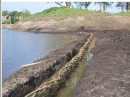
soort beschoeiing: paalwiepenbeschoeiing functie: tijdelijk behoud doorstroomprofiel
