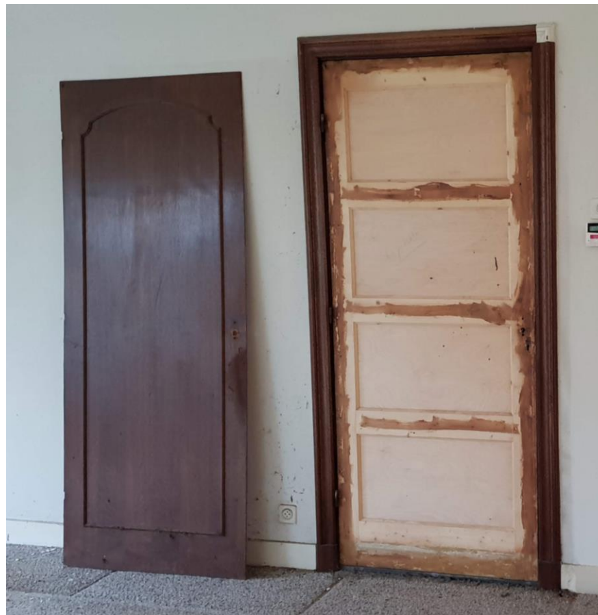
Afbeelding: Verwijderde eiken fineer van de Bruynzeel deur in de woonkamer. (foto van Dhr. Braks)
