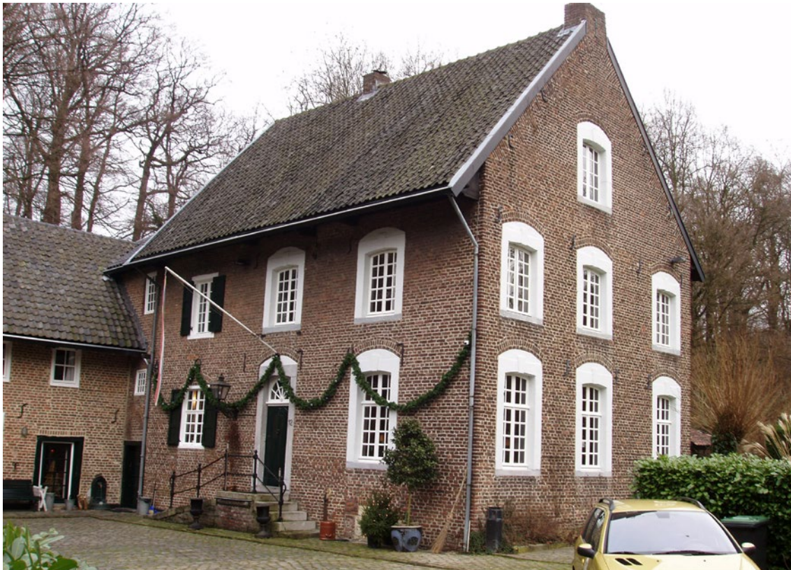
Boven: De Causermolen bij de Causerbeek aan de voet van de Molenberg in het Aambos (bron: http://rijksmonumenten.nl ).
